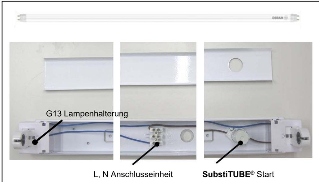
*Sicherstellen, dass die Umverdrahtung komplett durchgeführt und fertiggestellt wird, um Schäden, z.B. durch Kurzschluss, zu vermeiden*
