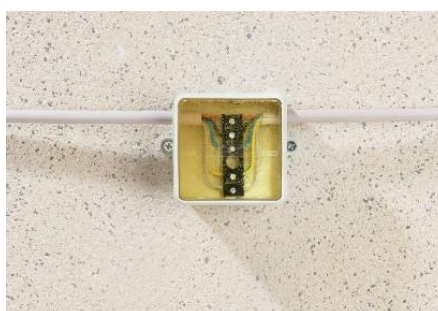
8. Die Verkabelung in dem Abzweigkasten ist nun 100% wasserdicht
