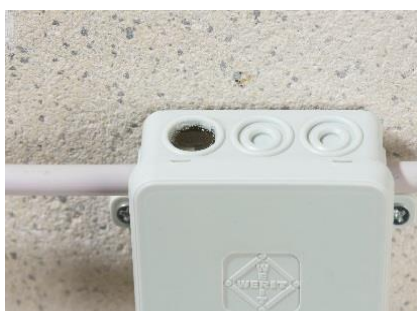
7. Kompletten Abzweigkasten mit ISO FLEX Gel befüllen. Nach ca. 50 Minuten ist das ISO FLEX Gel getrocknet und ausgehärtet
