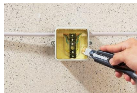
9. Bei Bedarf kann das ISO FLEX Gel wieder aus dem Abzweigkasten entfernt werden
