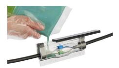
11. ISO FLEX Gießharz in die Muffe einfüllen.
