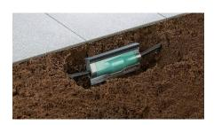
14. Nach dem Aushärten ist die Muffe 100% wasserdicht und trittfest.
